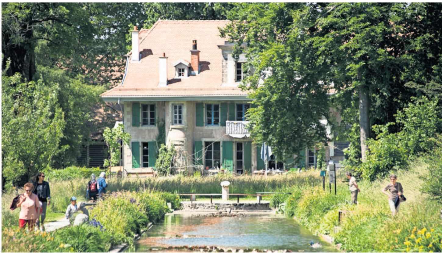
En piteux état, la Maison du Désert sera transformée en Maison de quartier proposant des locaux multi-usages. 24HEURES
